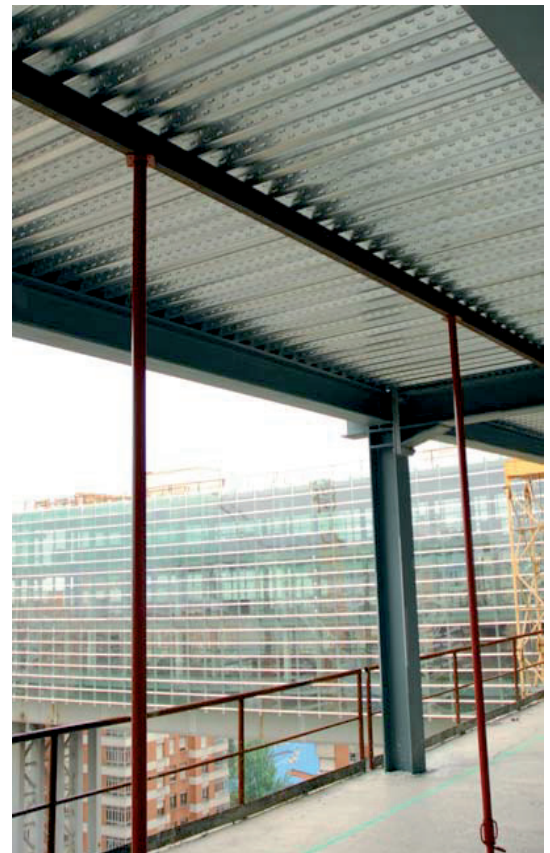
Imagen apuntalamiento provisional
